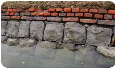
▲圖2-19-1 由三角石插入岸壁構築而成的護岸石牆
