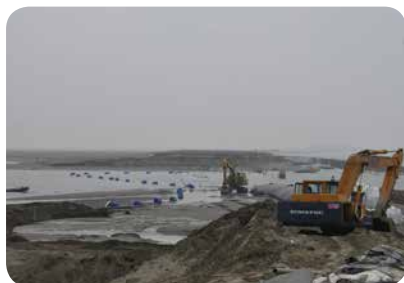
▲圖2-29 工程人員正忙碌施工
