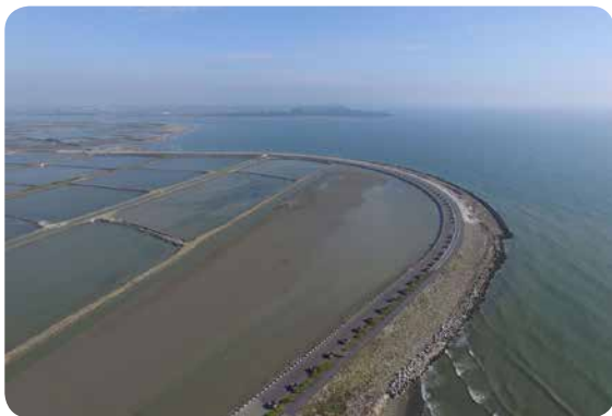
▲圖3-30 曾文溪口北側這段堤防，遠較兩側為新
