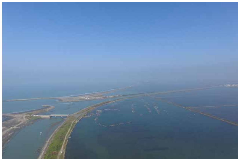
▲圖2-23 西南航道隔開北側的一工區與南側的二工區，右方為青鯤鯓
