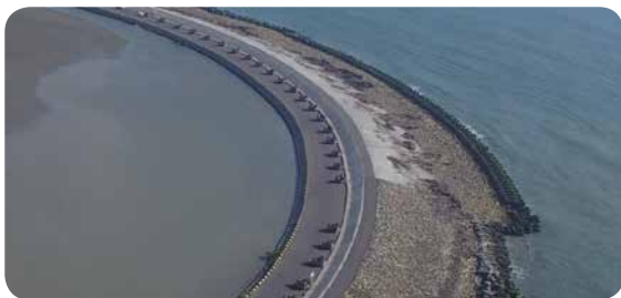
▲圖3-31 新建堤防靠海側(右邊)遠比靠陸側為緩，且有多層防護
